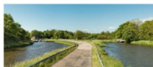
Écluse de Port-sur-Saône, bief 54 du versant Océan à Saint-Eusèbe.
