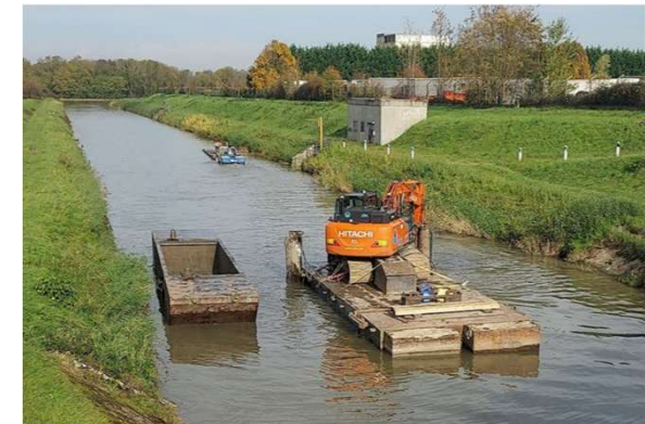
Bief 34 bis Med :Photo Anthony Paillard
